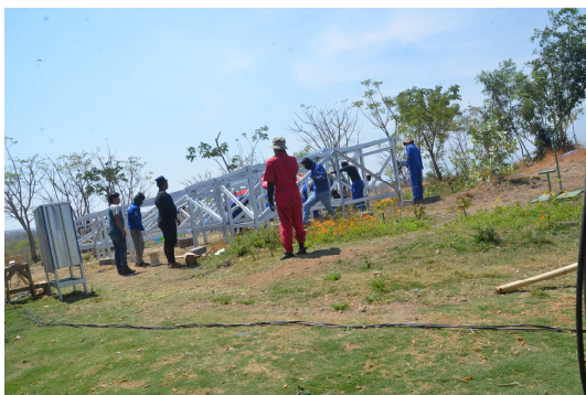
Gambar 7. Proses Pemasangan Peralatan (Mahasiswa Jurusan Teknik Elektro Unika Widya Mandala Surabaya, sebagai calon insinyur Indonesia)
